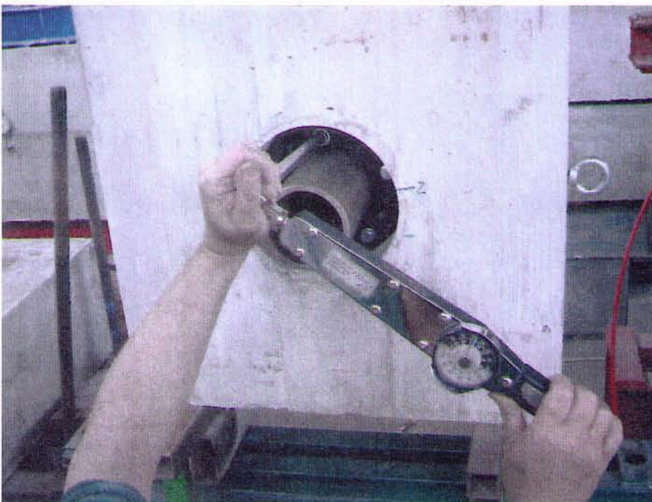
Bild 4: Anziehen der Schrauben im Uhrzeigersinn mit Drehmomentenschlüssel
